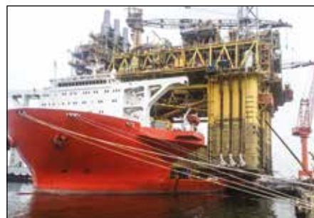
Монтаж и спуск их на воду
