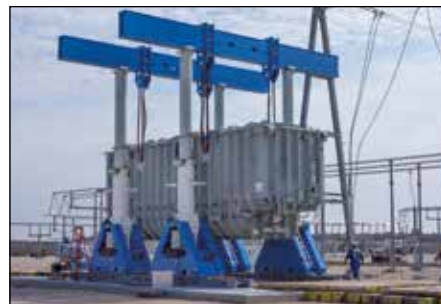
Высокоточный подъем и позиционирование
